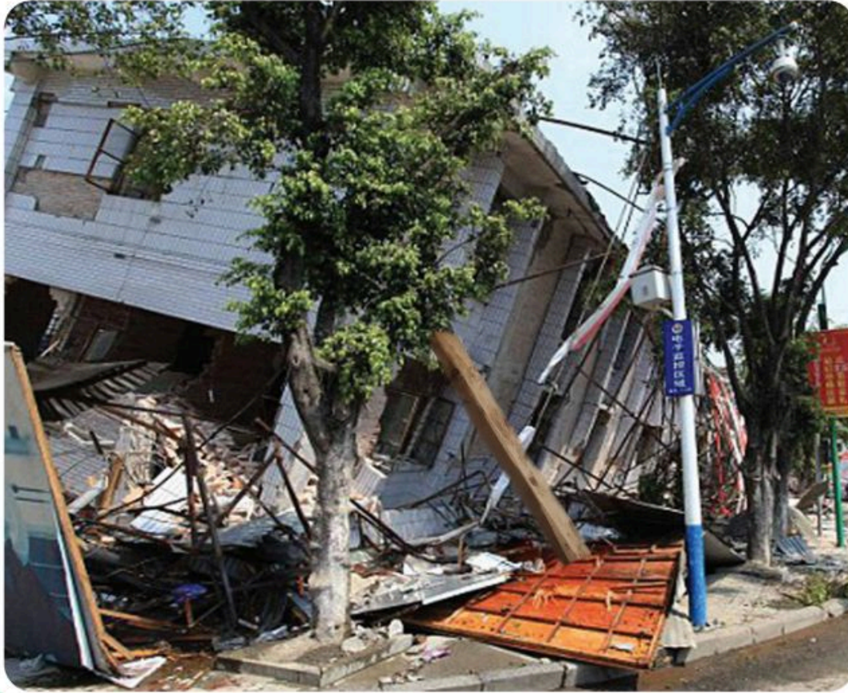
الشكل 32-6 المباني الخرسانية (الأسمنتية) هشة غالباً، ويمكن أن تتلف بسهولة إذا وقع زلزال؛ فالمبنى الظاهر في الصورة أزيح من فوق أساسه عندما حدث الزلزال، وتم إسناده بعمود من الخشب.
