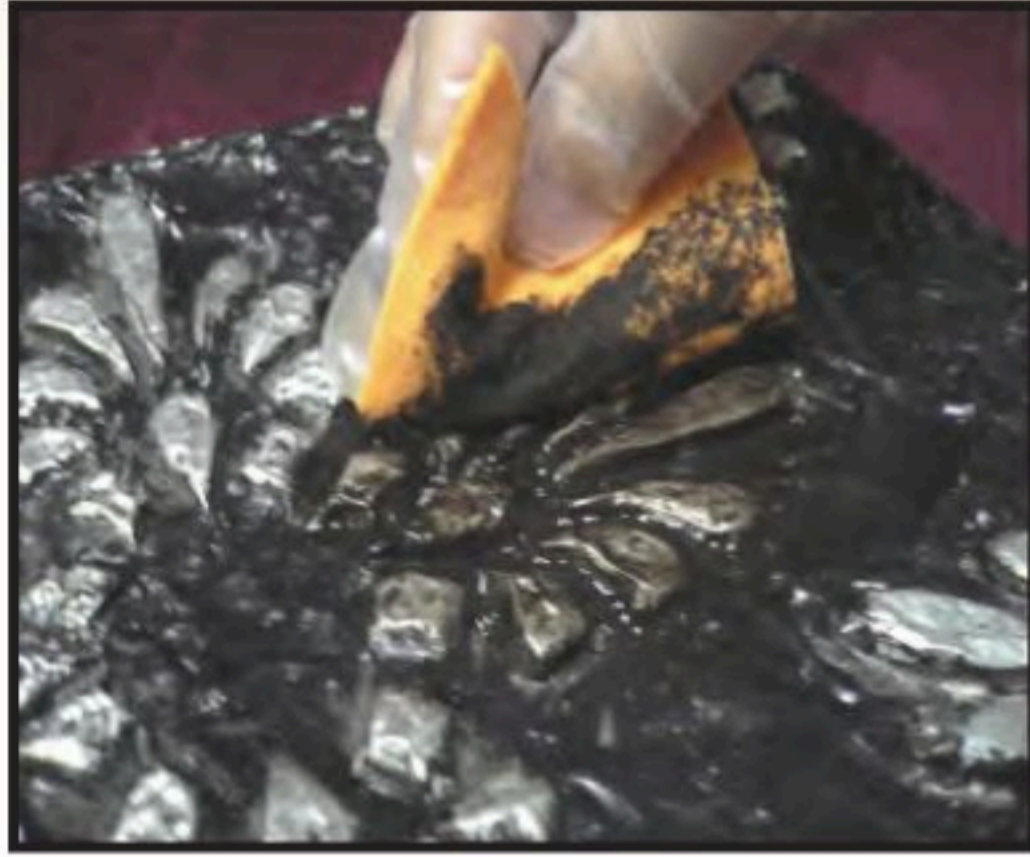
الشكل (٨٩): استخدام التتر.
