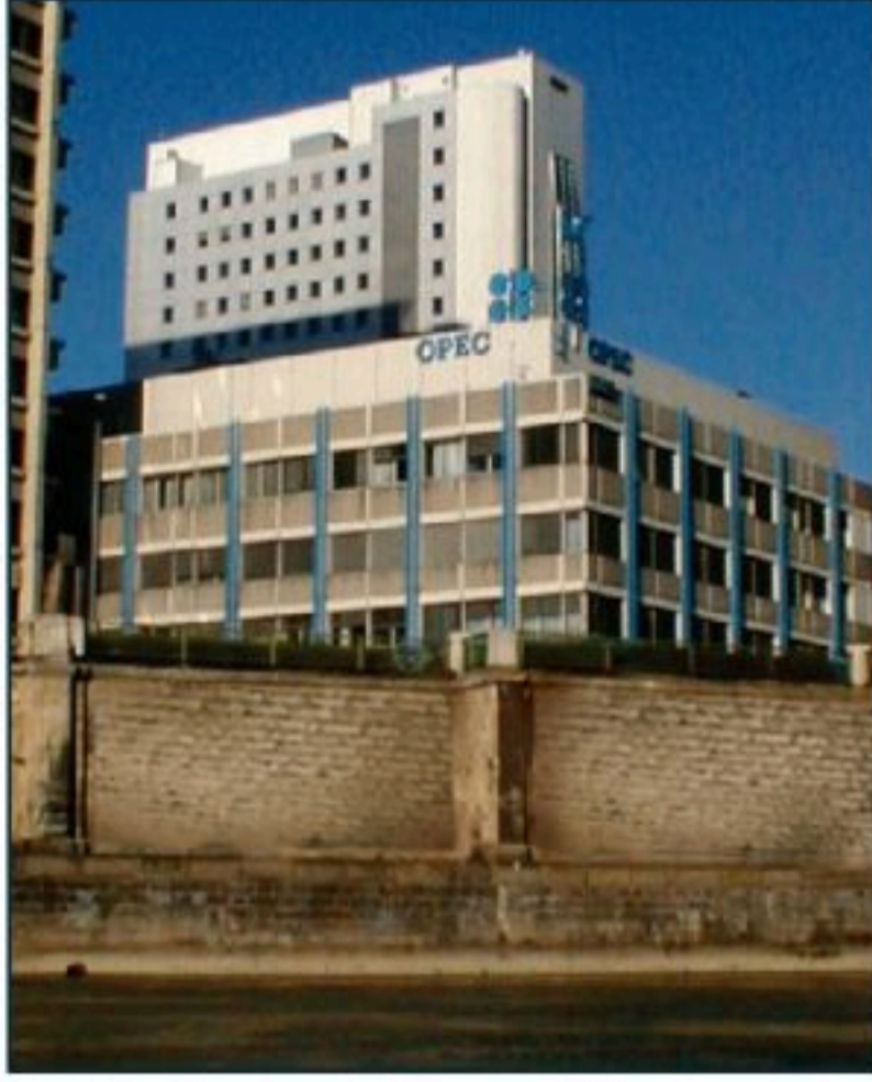
▲ مبنى منظمة أوبك في فيينا
