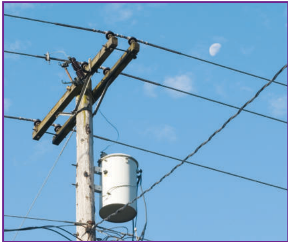
هناك أدوات تُسمى المحولات تستعمل المغناطيسية لخفض التيار الكهربائي إلى قدرٍ مناسبٍ ليستخدم في المنازل.
